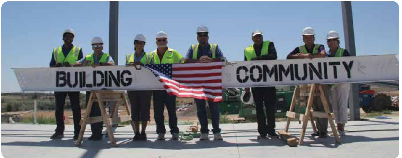
Los miembros del Concejo Municipal celebran la colocación de la última viga del techo del nuevo centro recreativo.
